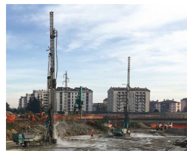
5A e 5B. L'esecuzione di tamponi di fondo mediante tecnica in jet grouting
