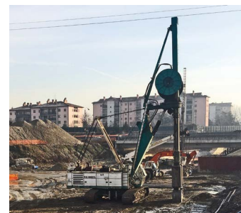
4A e 4B. L'esecuzione di due paratie perimetrali per il sostegno del terreno in fase di scavo
